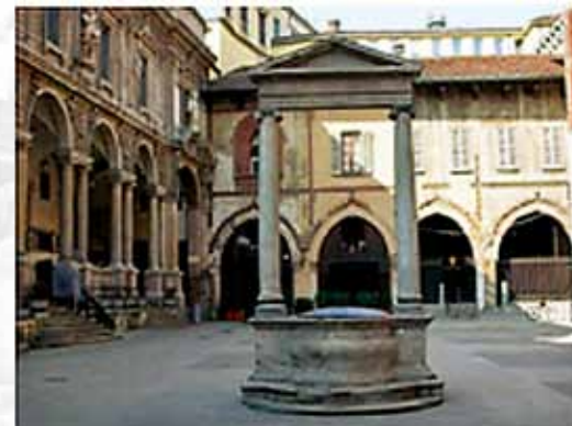
Loggia dei Mercanti (Milano)
