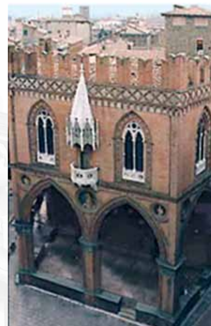
Loggia dei Mercanti (Bologna)
