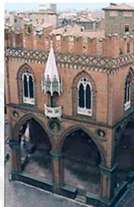
Loggia dei Mercanti (Bologna)
