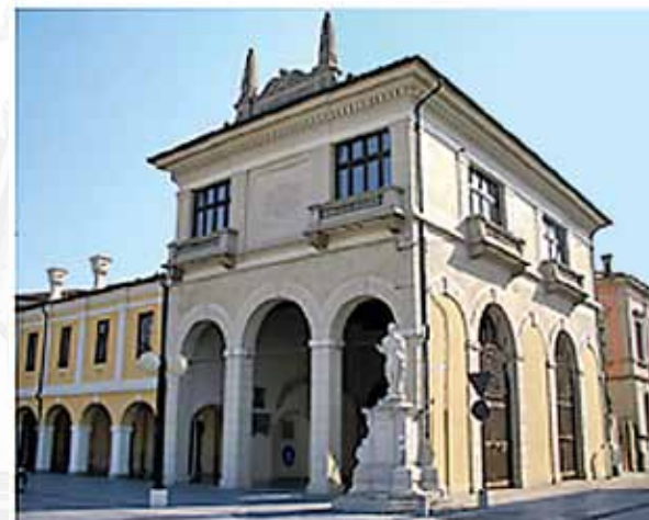
Loggia dei Mercanti (Palmanova)
