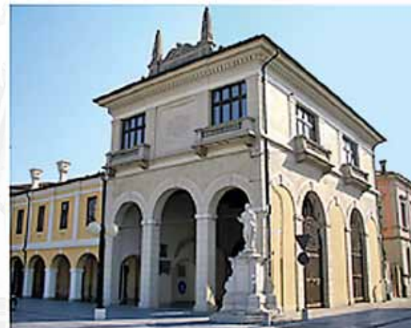
Loggia dei Mercanti (Palmanova)
