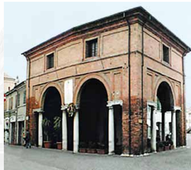
Loggia dei Mercanti del grano (Comacchio)
